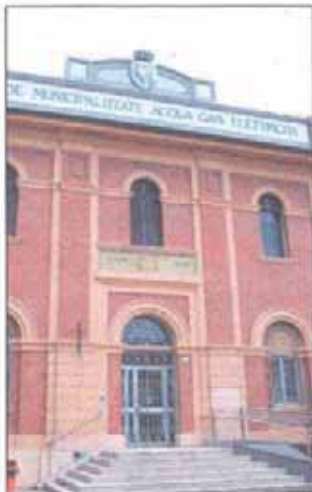
Sopra, la sede del Con.Ami in via Mentana. Il Consorzio imolese è tra i sostenitori di questo concorso che premia i giovani progetti ad alto contenuto tecnologico
