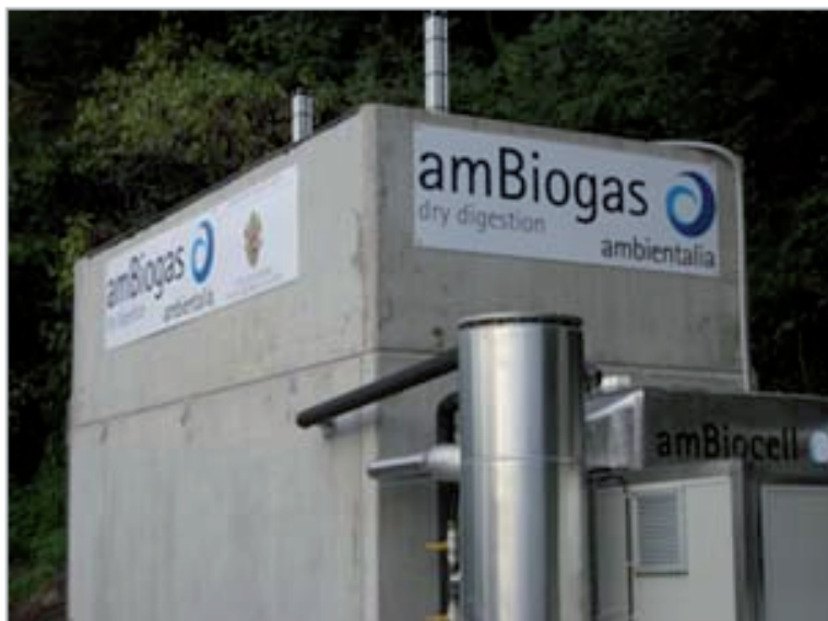
L'impianto di compostaggio amBiogas di Ambientalia
